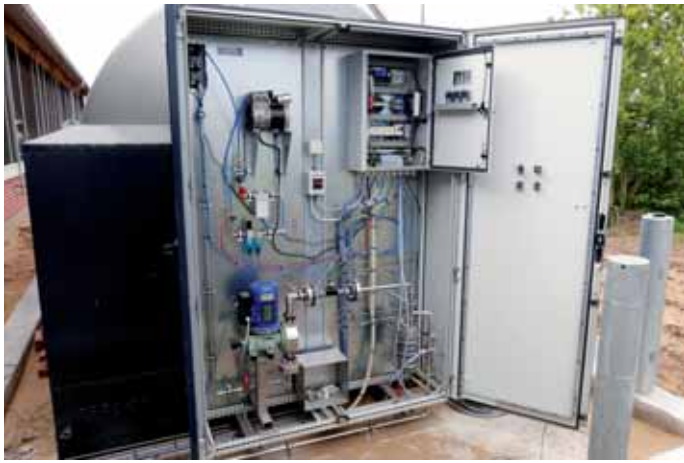
Fot. 3. Komputerowy system sterowania procesu zakwaszania gnojowicy.
